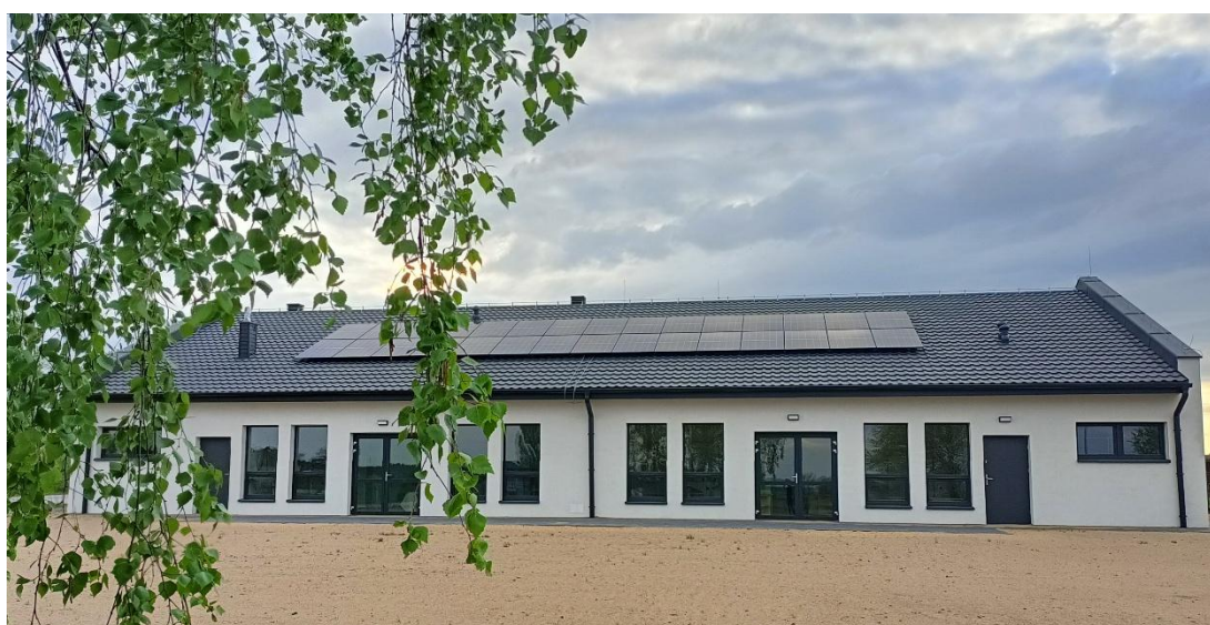
Fot. Budynek żłobka w Kamieniu Krajeńskim
