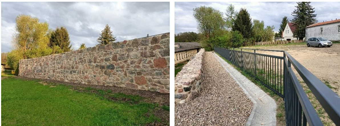
Fot. Mury miejskie w Kamieniu Krajeńskim po zakończeniu prac konserwatorskich
